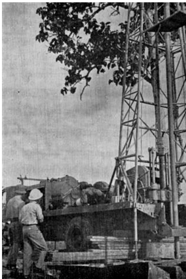
หน่วยเจาะน้ำบาดาลของไทยกำลังเจาะน้ำที่หน่วยงาน
