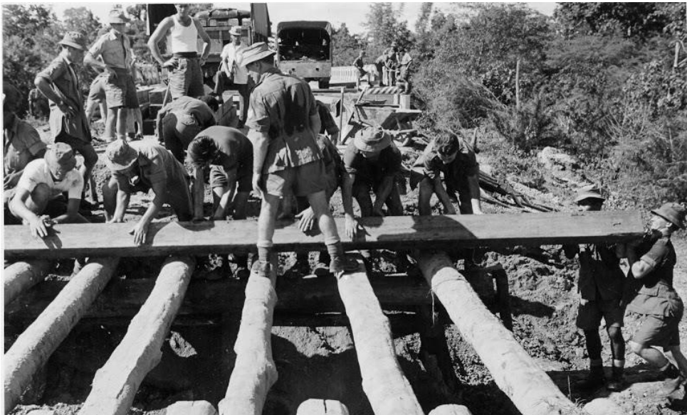
ทหารช่างอังกฤษกำลังซ่อมสะพาน - กันยายน ๒๕๐๗
